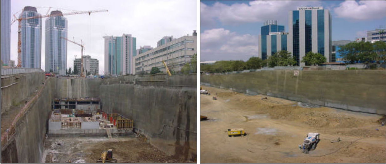
Sekil 6 : Tekfen Tower H_{maks} = 24.0m ve Eczacıbaşı Atrium H_{maks} = 28.0m Projeleri Pasif Ankrajlı İksa Sistemleri (İstanbul/Levent) (Yılmaz ve diğerleri, 2000)
