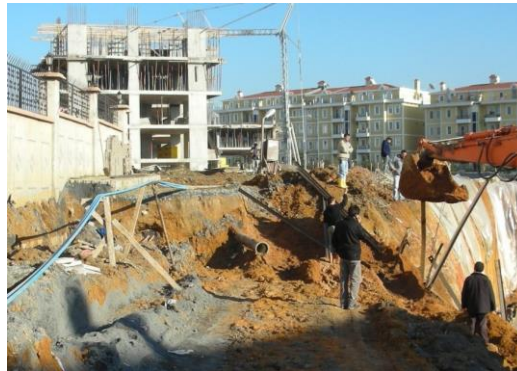
Şekil 2. Kırılan Su Borusu
